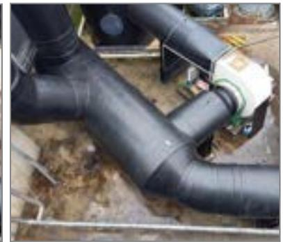
*Avant/après mise en place du plénum où se mélange les flux d'air vicié*
