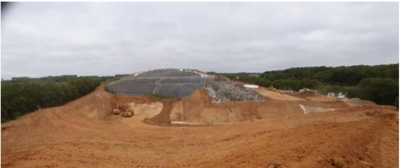
*Photo du 02/06/2023 : Terrassement C4A8 et rehausse digue C4A7*
