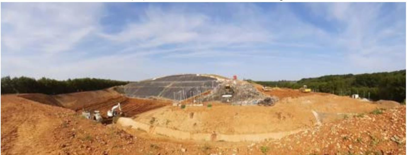
*Photo du 15/06/2023 : mise en oeuvre BSP dans C4A8 et rehausse de digue C4A7*
