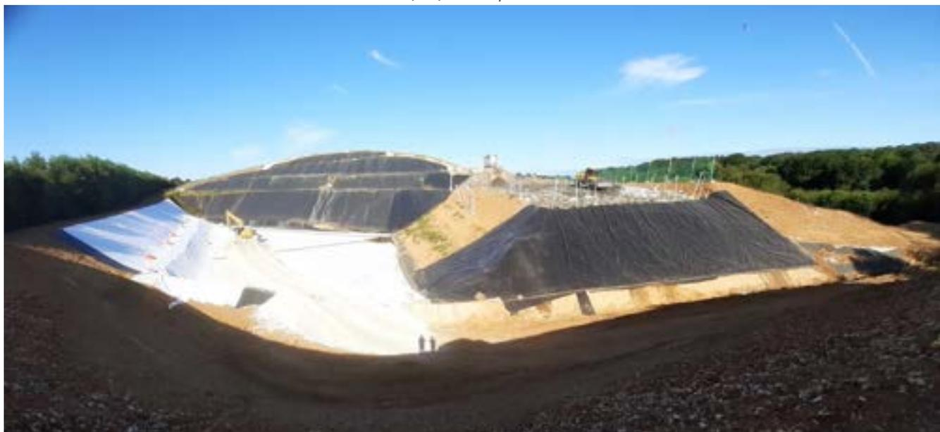
*Photo du 11/07/2023 : pose couche drainante C4A8 et parement C4A7 / C4A9*
