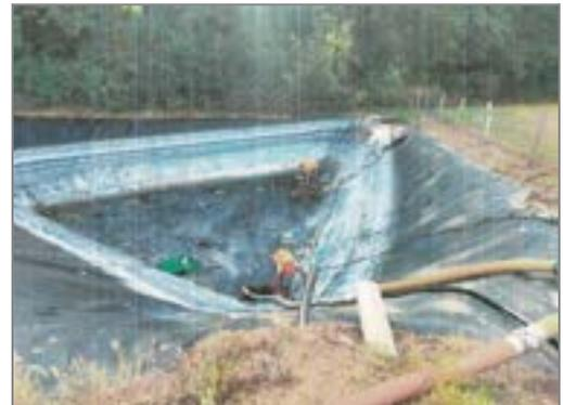
Contrôle diélectrique de l'étanchéité de la lagune
