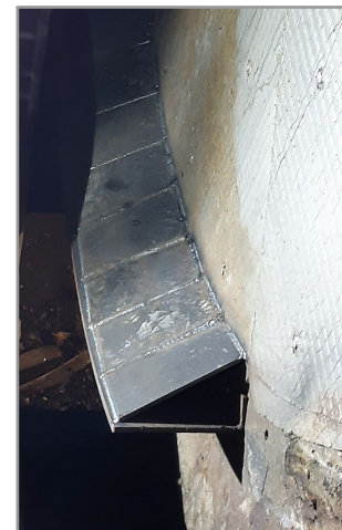
remplacement des écailles en entrée du BRS
