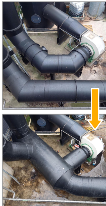
Mise en place d'un plenum pour mélanger les airs viciés
