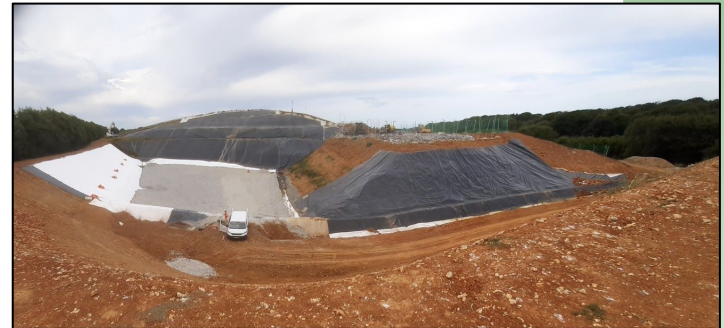
Fond d'alvéole C4A8 aménagée
