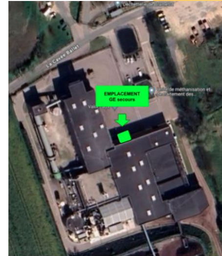
Positionnement du GE secours
