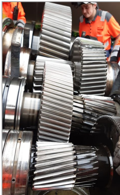
Remplacement des éléments du train d'engrenage du motoréducteur du BRS
