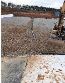
Mise en place du premier niveau altimétrique de drainage du biogaz en fond de Casier N°4 alvéole N°7.
