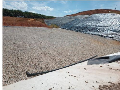
Modification du diamètre utile des réseaux de captage du biogaz à l'avancement de l'exploitation passant d'un Diamètre 110 mm à un Diamètre 160 mm.
